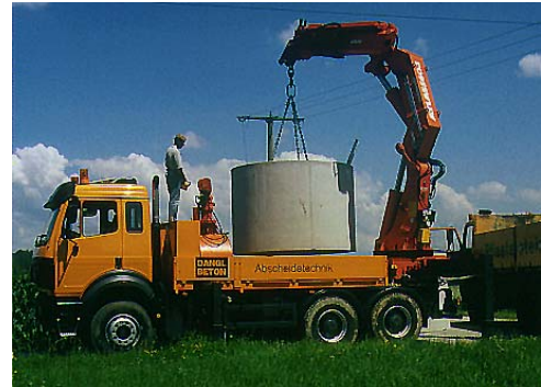
Transport mit werkseigenem Lkw-Schwerlastkranwagen und direktem Einheben in bauseitige Grube
